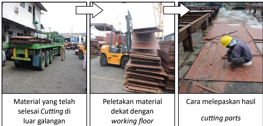
Gambar 3.4. Proses penanganan material yang di cutting sub-kontraktor.
