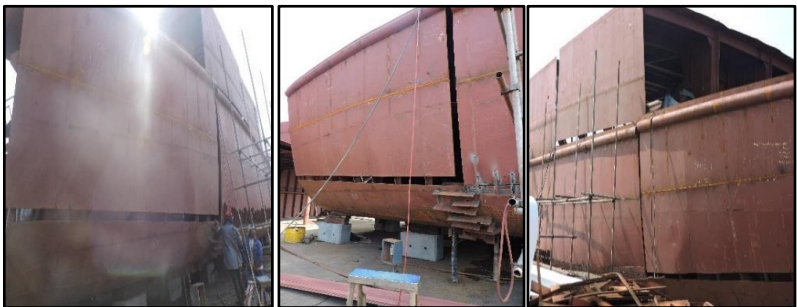
Gambar 3.7. Pekerjaan erection di galangan no 24.
